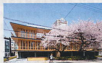
写真-3. 竣工写真*2
